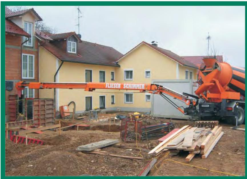
**Wo der Radlader nicht hinkommt,** füllt das LTB die Rollierung am Keller an und verteilt diese sogar. Die Bandgeschwindigkeit und die Trommel-drehzahl werden an der Fernbedie-nung je nach gewün-schter Förder-menge eingestellt.
