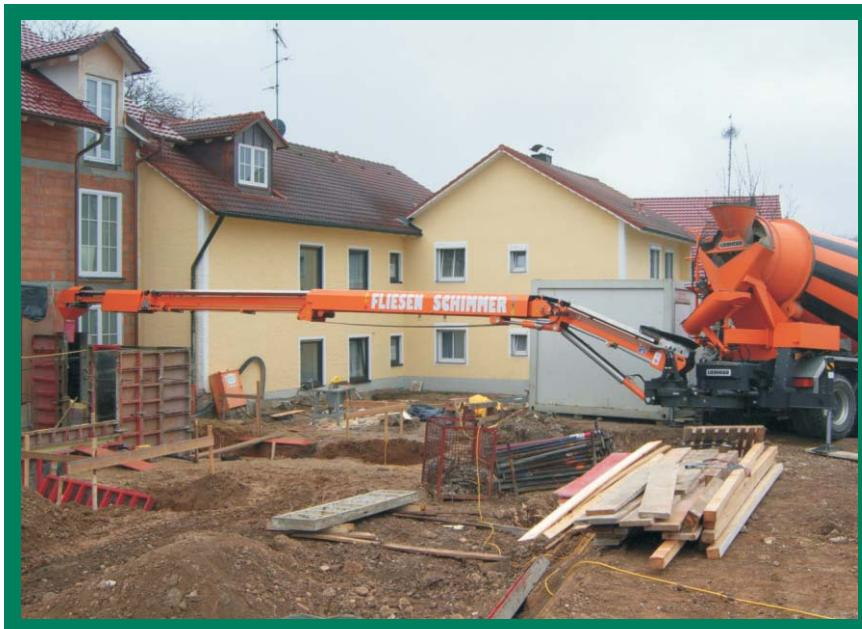
**Wo der Radlader nicht hinkommt**, füllt das LTB die Rollierung am Keller an und verteilt diese sogar. Die Bandgeschwindigkeit und die Trommelfrequenz werden an der Fernbedienung je nach gewünschter Fördermenge eingestellt.
